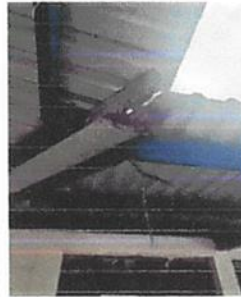
foto 4. sustitucion de canales y láminas del techo existen.
